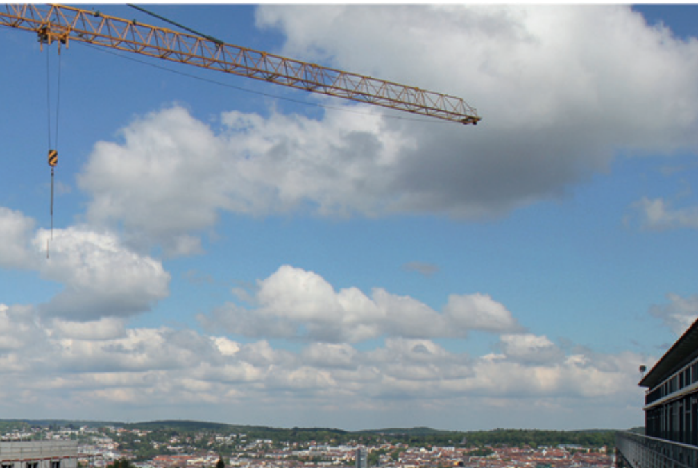
< So sah das neue Technikgebäude im Mai aus... Foto: Cornelia Kamper
