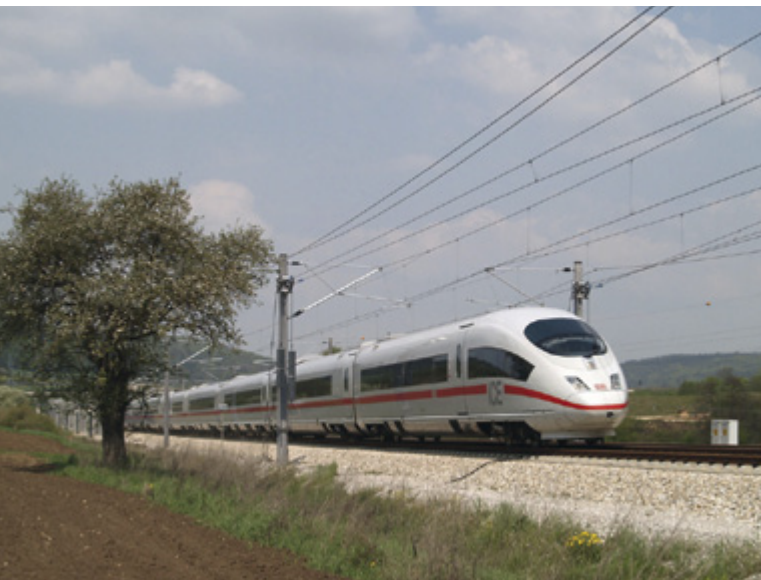
Abb. 1 Hochgeschwindigkeitsbahnstrecke Quelle: Deutsche Bahn AG / Claus Weber
