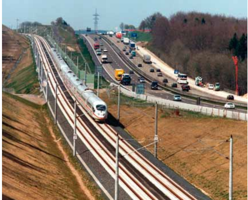
Hochgeschwindigkeitsbahnstrecke. Quelle: nkt cables GmbH
