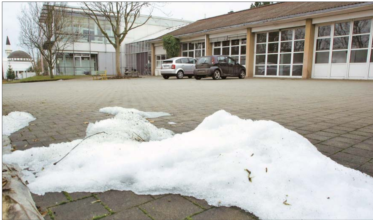
Aus Alt mach Neu: Die ehemalige Salzlagerhalle an der Eutinger Straße (rechts) könnte bald einem Neubau weichen.
