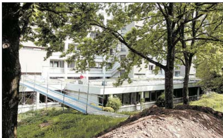
Ausbau II: Der Verwaltungstrakt wird aufgestockt.
